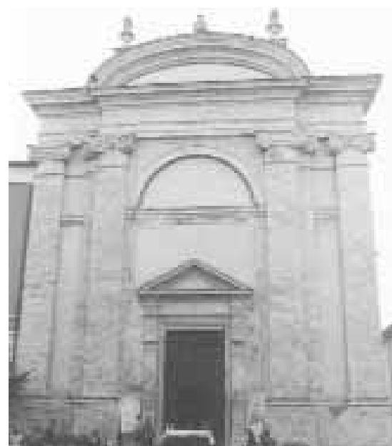
La chiesa dedicata alla Santa catanese (www.proloco.ferentino.fr.it/)
